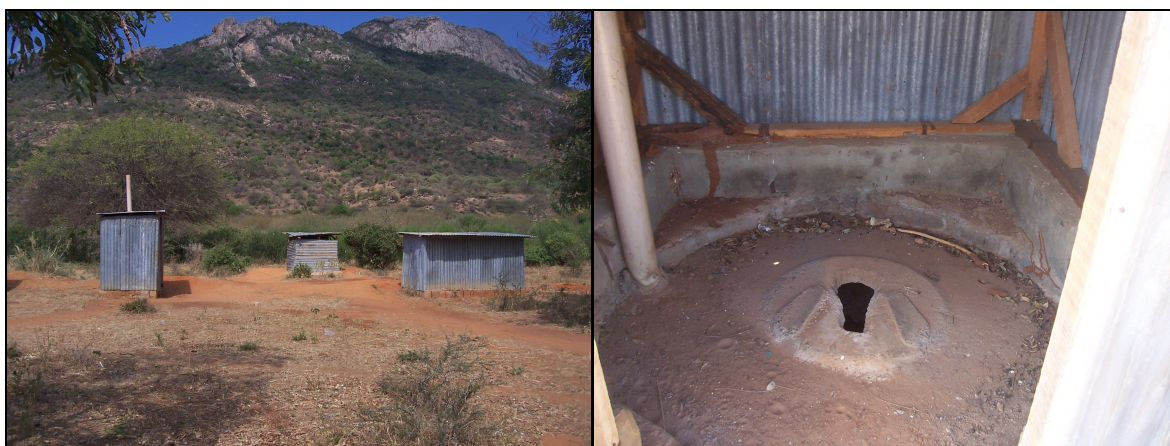
Figura 5.18: latrine della Hawecha Primary School
