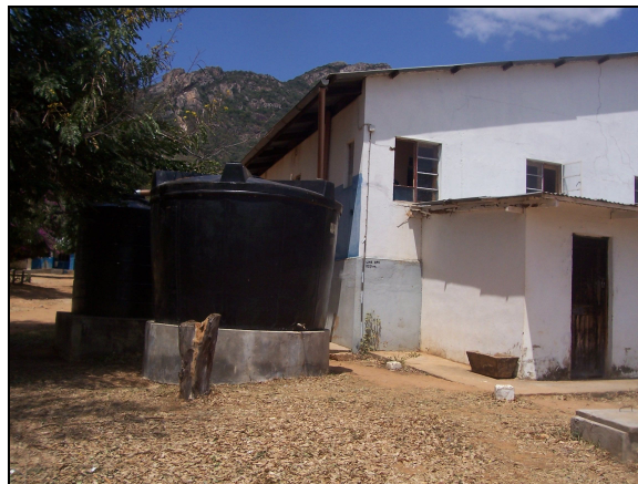
Figura 5.27: "roof catchment" reparto maternità
